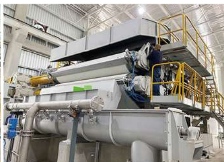
太阳纸业安装现场 15台压浆机运行中
