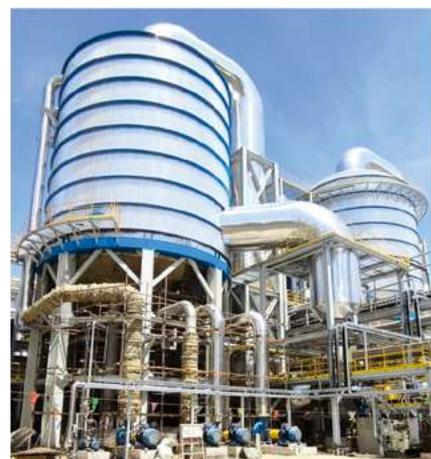
图9 B浆纸厂4台独立的MVR蒸发系统并联使用现场照片
