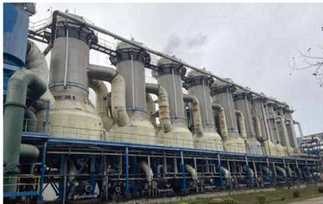
图3 A浆纸厂8效管式降膜蒸发系统现场照片
