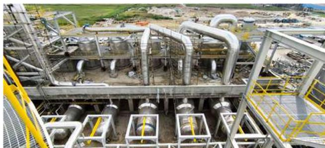
图12 B浆纸厂FC蒸发系统使用现场照片
