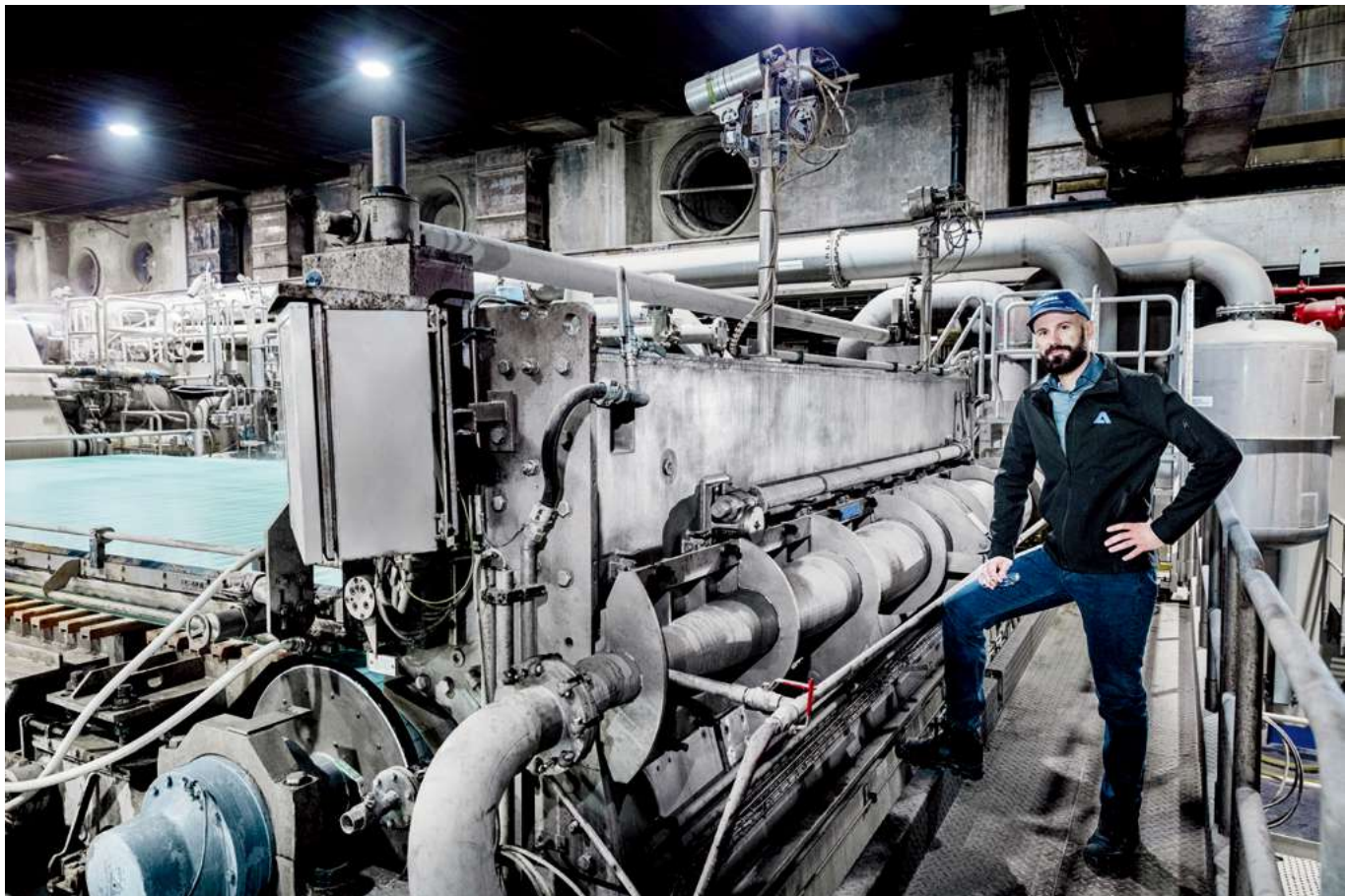
KM3项目PrimeFlow AT流浆箱
